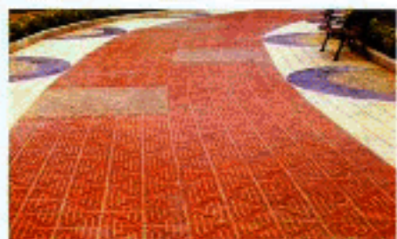
水泥石屑铺地(见 1/16)
