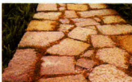
花岗岩石板铺地(见 2/17)
